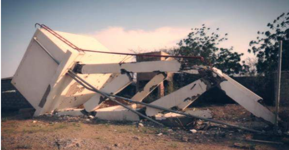
خزان مياه شرب فجره الحوثيون في حجة.
